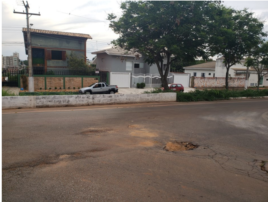
FIGURA 10 – MURETA PARA DIMINUIR A FORÇA DA ÁGUA
