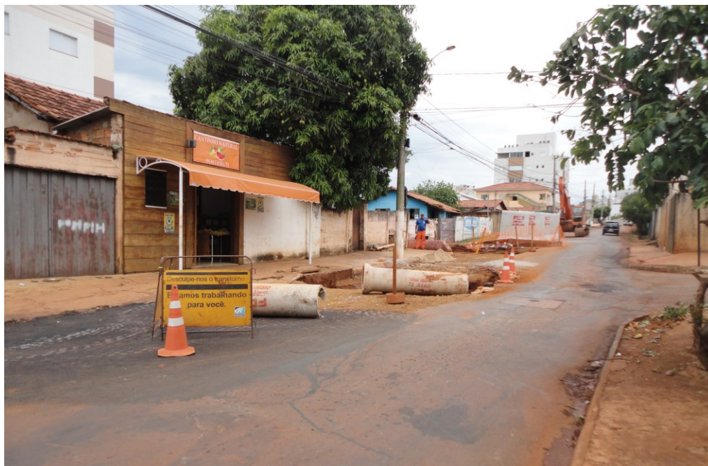
FIGURA 11 – OBRA PARA IMPEDIR O LANÇAMENTO DE ESGOTO NA REDE DE DRENAGEM
