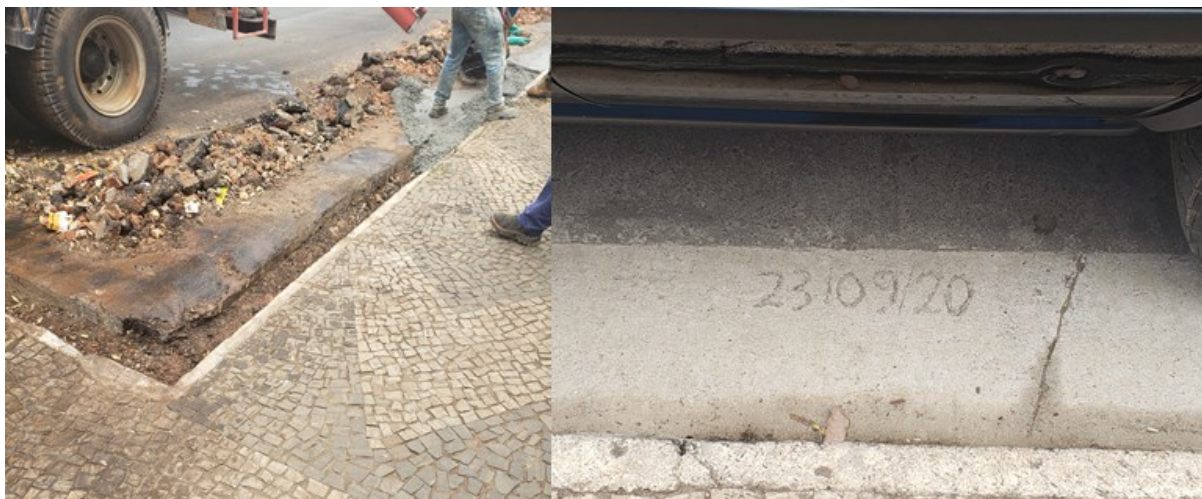
FIGURA 8 – SARJETAS SENDO CONSTRUÍDAS
