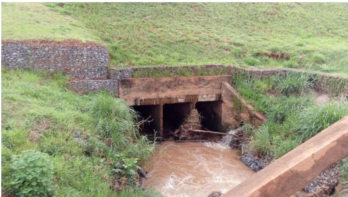
Figura 10 – Foto do emboque do Bueiro sob a Avenida JK
