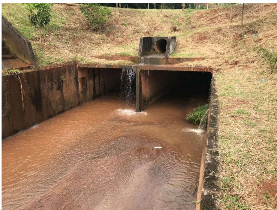
Figura 1 – Seção da Galeria do Córrego Monjolo imediatamente a montante da canalização a céu aberto
